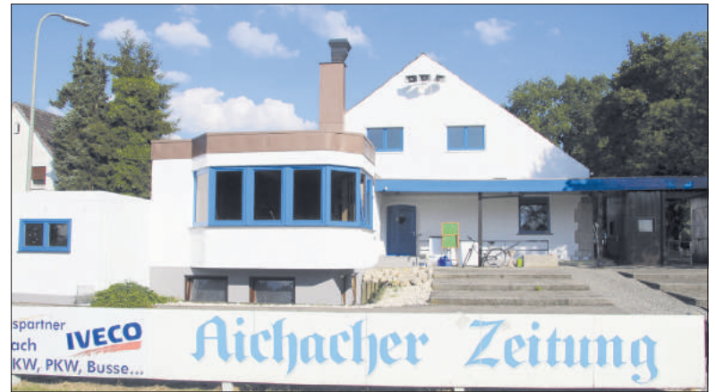
Das Clubheim mit dem Geschäftszimmer des BCA (im Vordergrund) wurde in diesem Jahr modernisiert. Es wurde 1968 gebaut und wird derzeit als Pizzeria betrieben.
